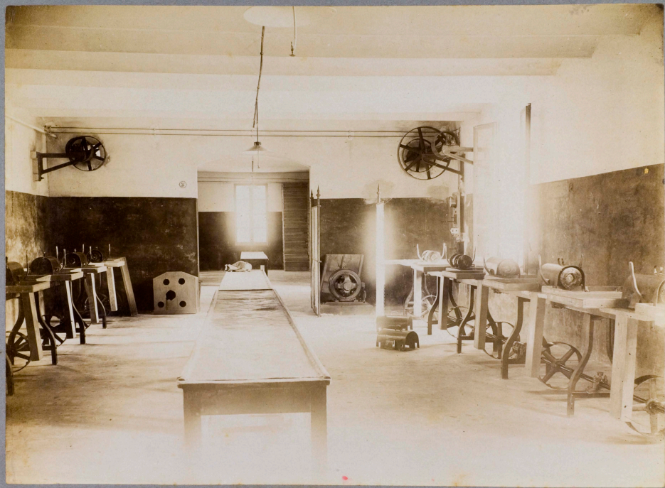
Parte dell' officina per il pulimento a mano ed a macchina delle scatolette già sterilizzate
