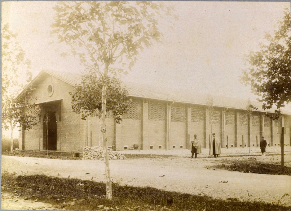
Una delle tettoie per deposito di fieno compresso in balle (capacità quintali 2500)
