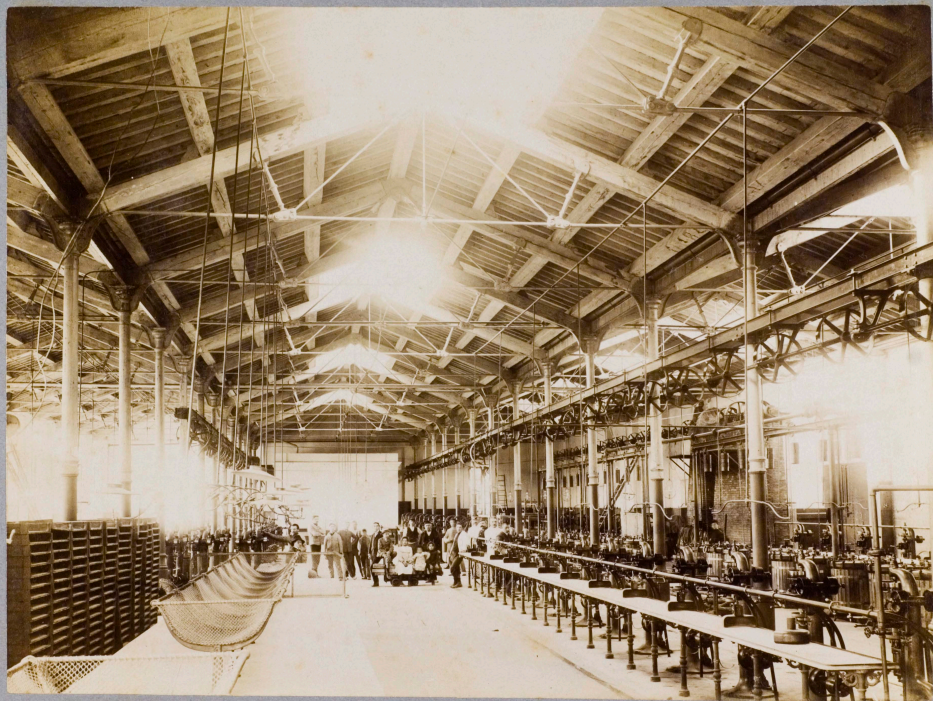
Parte della grande sala per la lavorazione delle scatolette (banchi dei brodisti e degli inscatolatori — Macchine aggraffatrici di scatolette ripiene)
