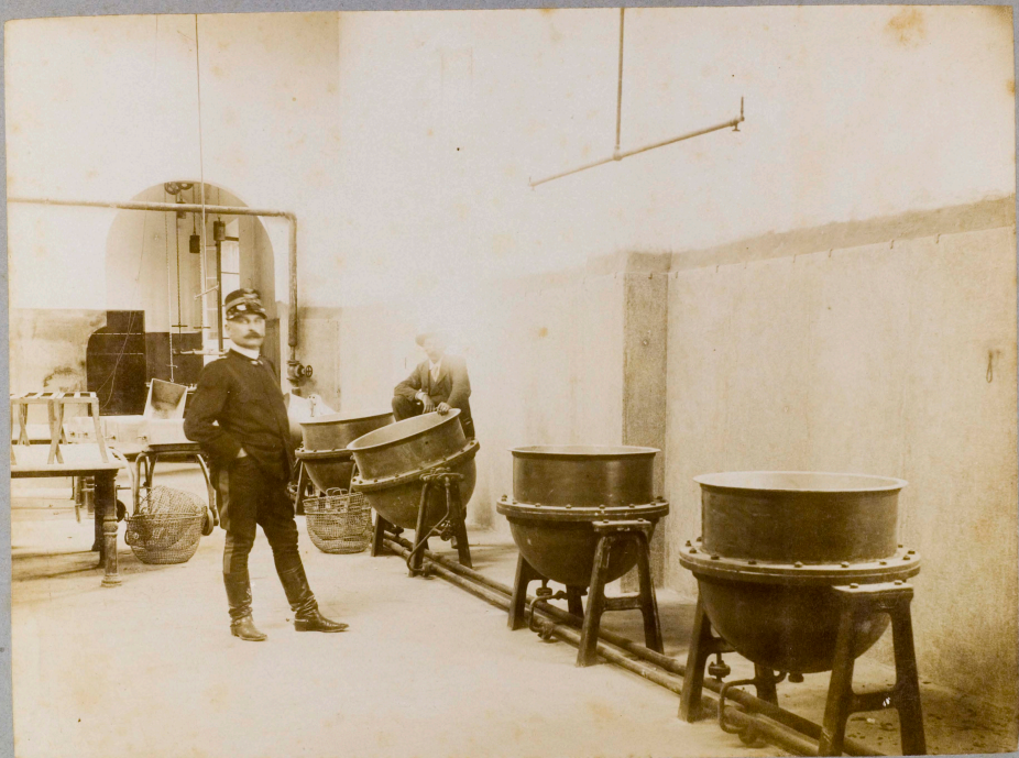
Batteria di caldaie di rame, a doppio fondo, girevoli, per la 1. a cottura della carne
