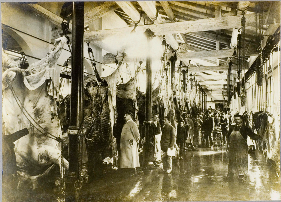
Il grande macello (carico) della capacità di 80 buoi
