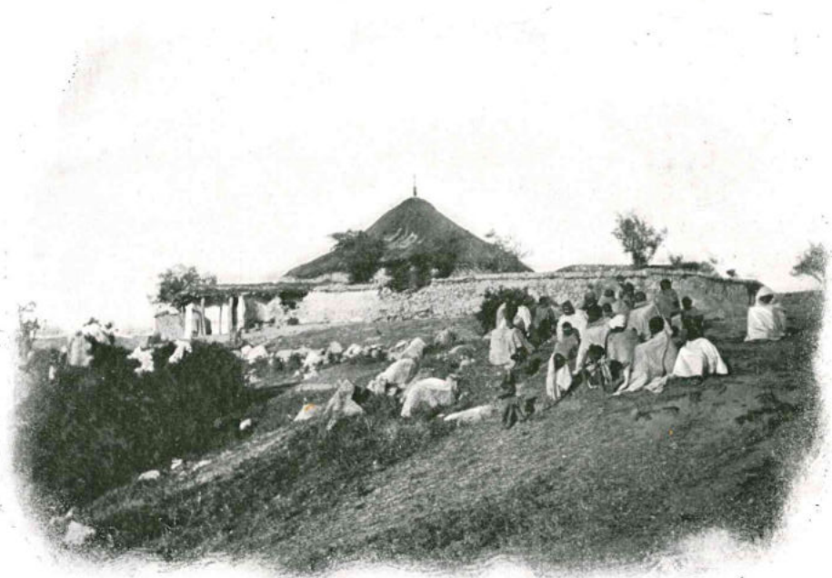
GLI ABITANTI DI AZ TECLESÀN MIRANO È PIANGONO L'INCENDIO DI AGOTRÌ.
