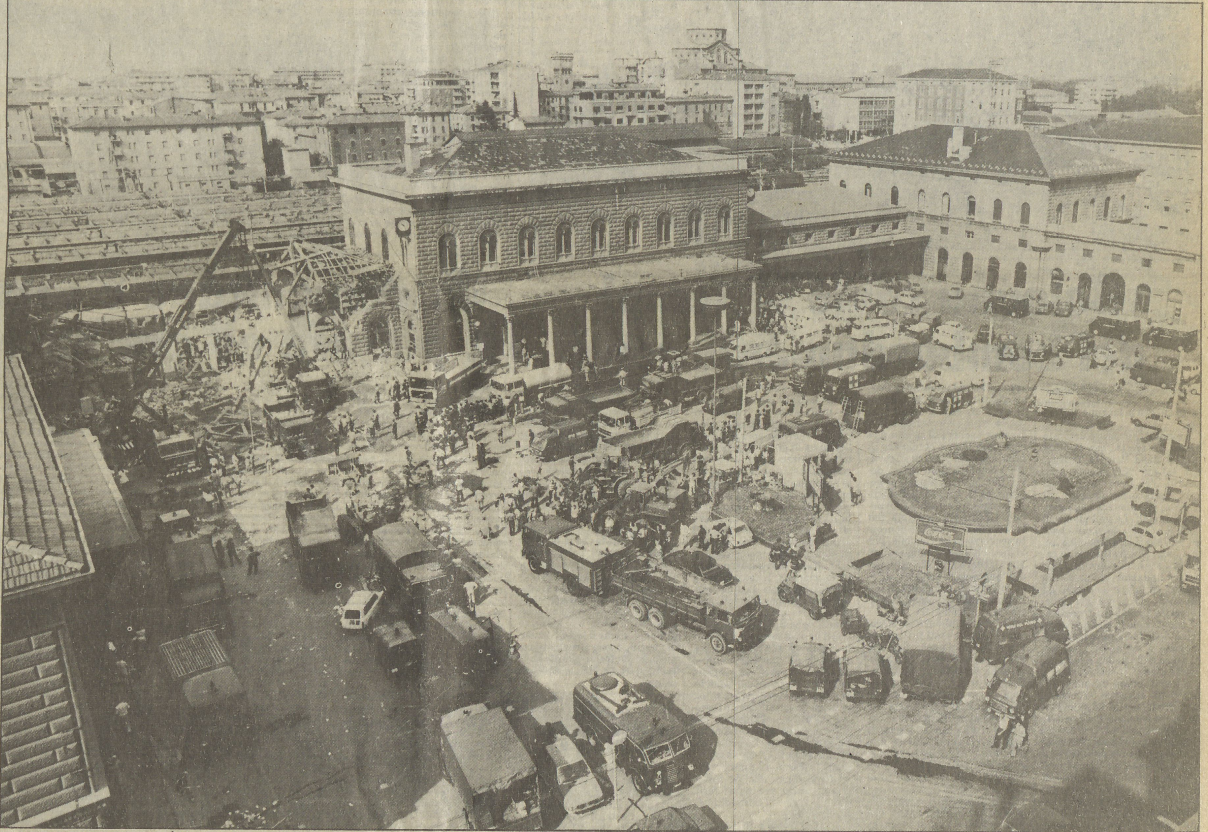
2 agosto 1980: questo è il piazzale della stazione di Bologna dopo la terrificante esplosione che ha completamente distrutto il fabbricato che collegava il corpo centrale all'ala ovest.
