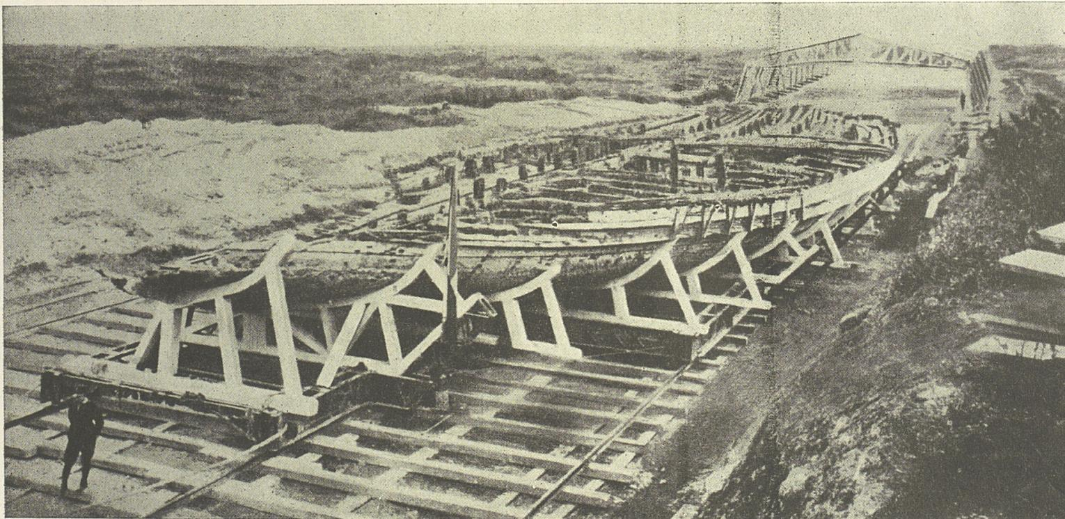
Avendo l'ingegnere Guido Uccelli, nel 1931, prosciugato il lago di Nemi, la marina italiana potè, poi, dalla rimanente acqua estrarre e condurre in secco la prima delle due galere di Caligola, lunga 70 metri e larga 17 metri e cinquanta centimetri. Qualora fosse stata armata per la navigazione, doveva raggiungere la lunghezza di 80 metri.
