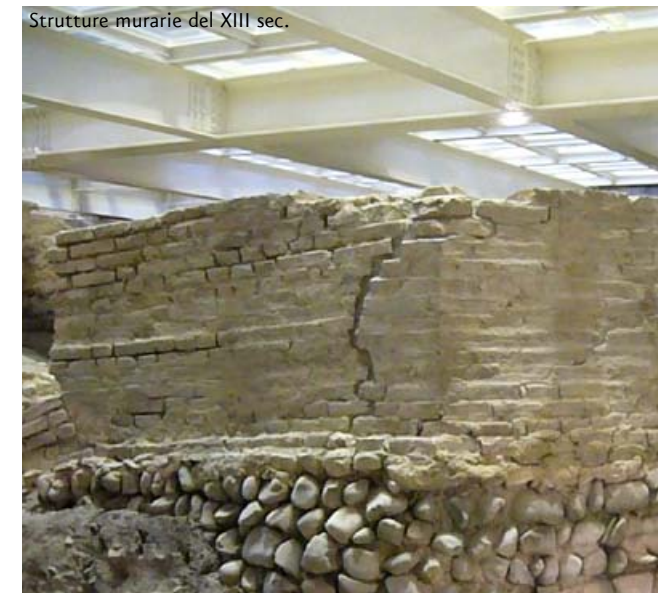
Strutture murarie del XIII sec.
