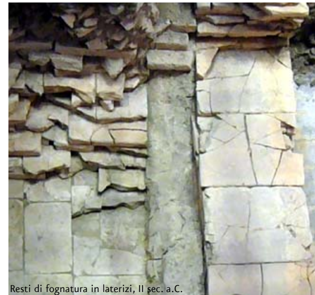
Resti di fognatura in laterizi, II sec. a.C.
